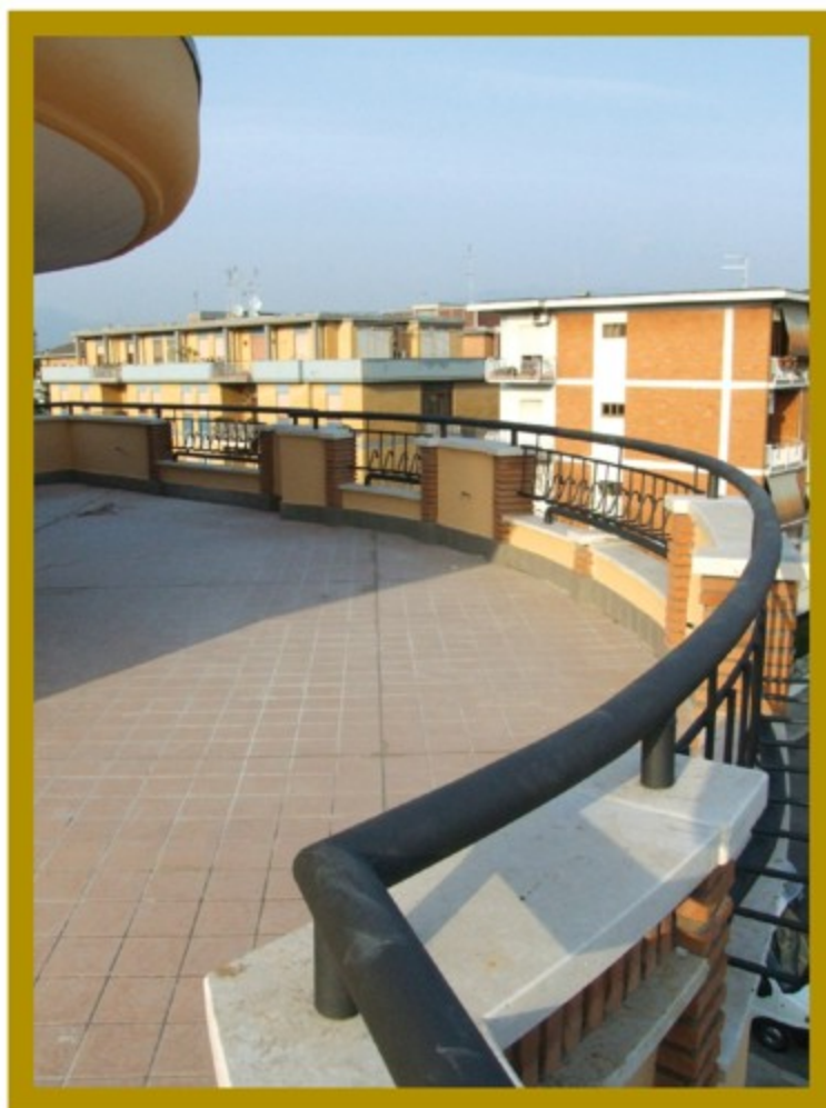
Realizzazione di elementi accessori in ferro per palazzi
